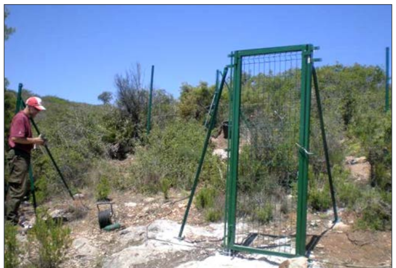
Instalación de vallado para protección de refugio de murciélagos. Foto: Raúl Serrano (Brigadas de Biodiversidad).
