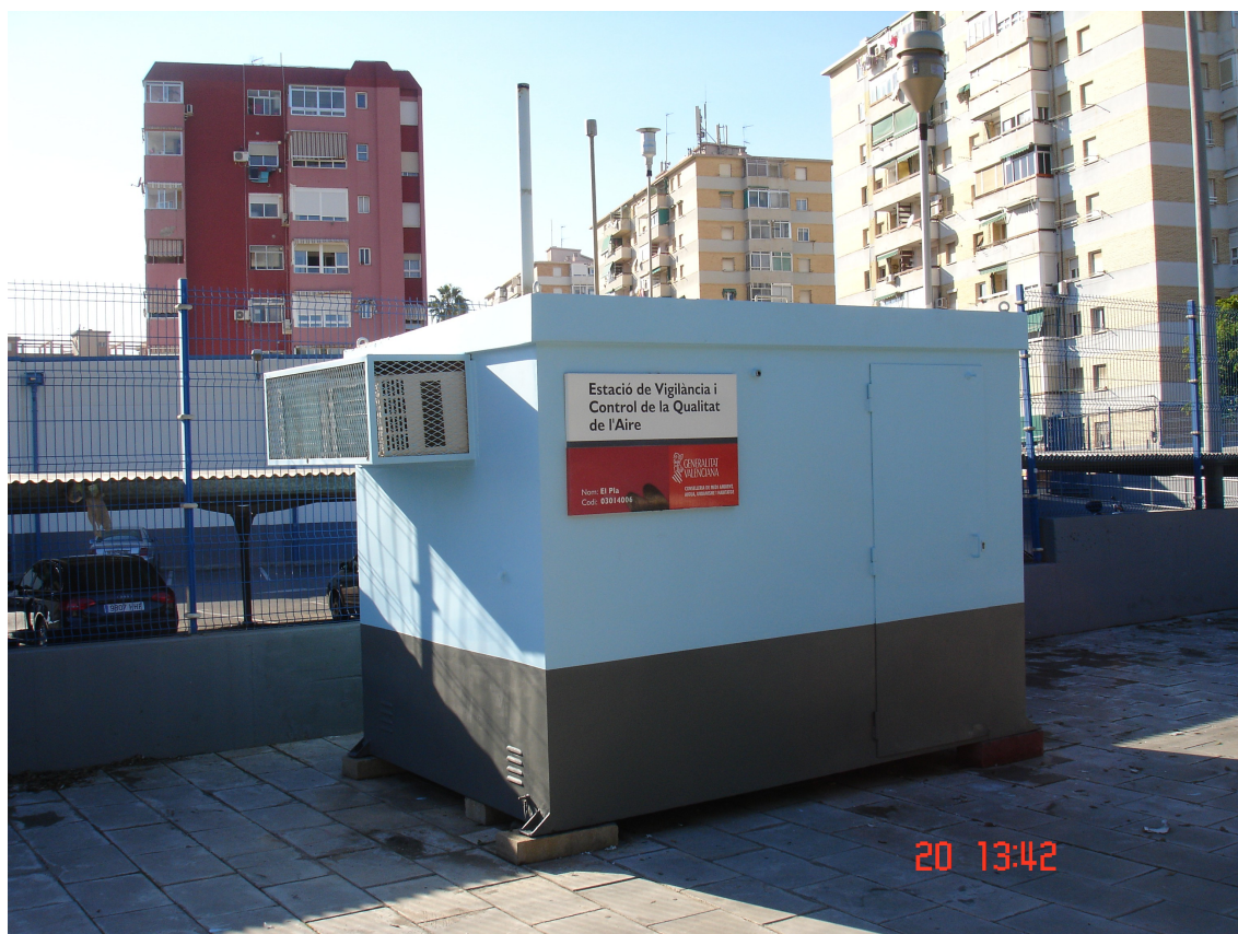
Foto: Estación de ALACANT-EL PLÀ
